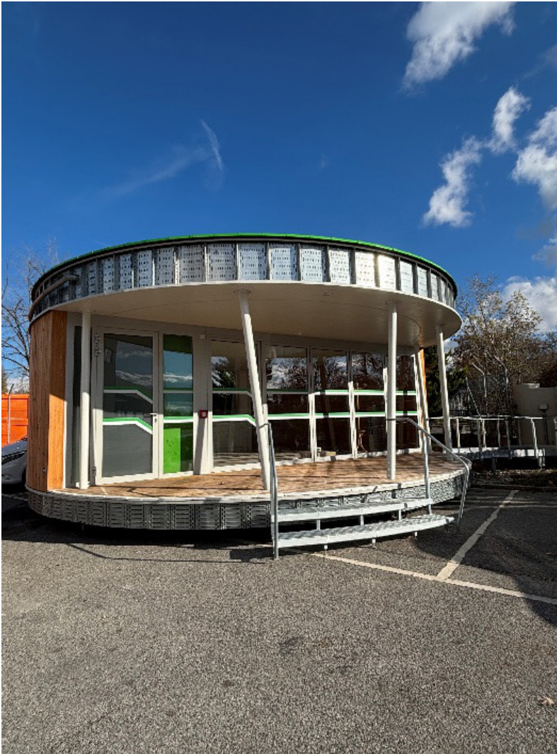
Abbildung 20: Fassade des Circular Center der Wien Energie, ausgestattet mit wiederverwendeten Kabeltrassen aus der Technisch-Gewerblichen Abendschule, Planung: Arch. Nikolas Kichler (vivihouse) © vivihouse
