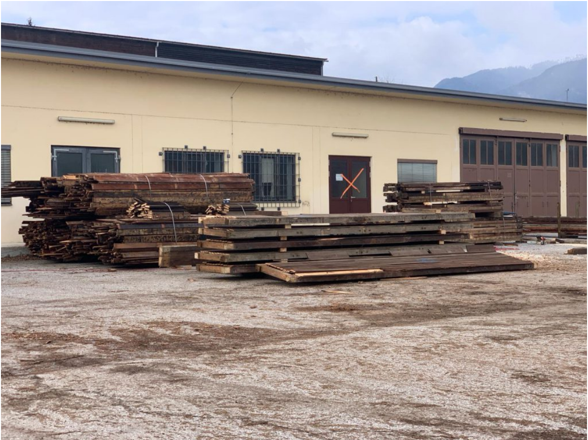
Abbildung 17: Systematischer Rückbau von hölzernen Fahrzeugunterständen in der Henselkaserne Villach durch eine lokale Zimmerei © BauKarussell e. Gen
