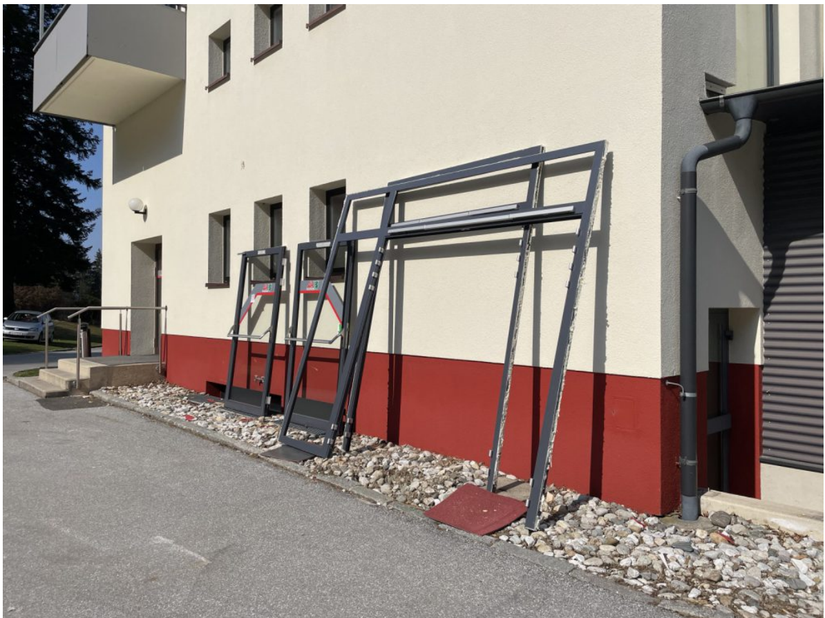
Abbildung 7: Zerstörungsfreier Ausbau von Türportalen in der Otto-Möbes-Akademie für den Wiedereinsatz in einer Sporthalle © BauKarussell e. Gen
