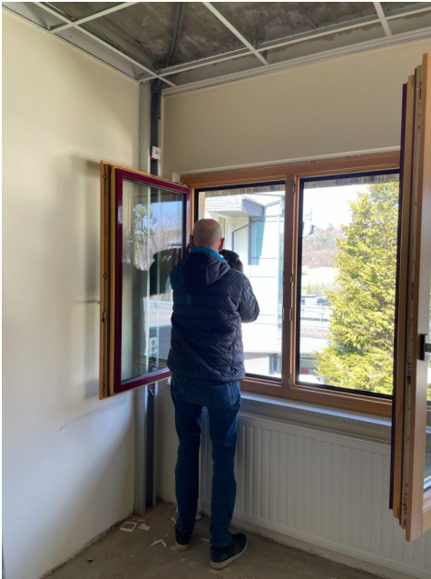
Abbildung 8: Zerstörungsfreier Ausbau von Holz-Alufenstern in der Otto-Möbes-Akademie für den Wiedereinsatz in einer Sporthalle © BauKarussell e. Gen
