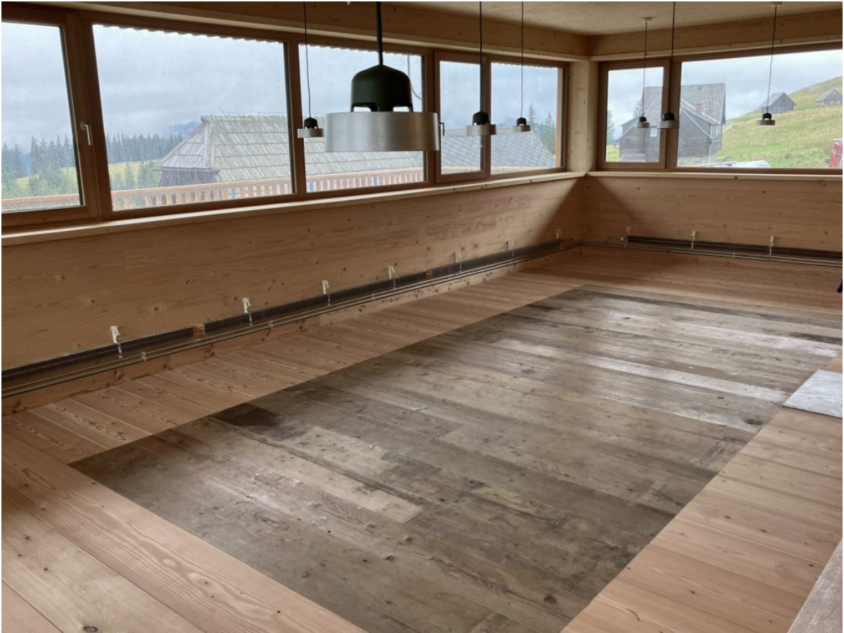
Abbildung 15: Projektbeispiel: DTFLR Ersatzneubau Hinternalmhaus ©DTFLR
