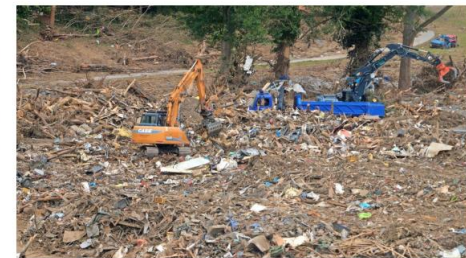
Bisher oftmals noch eine mühsame Angelegenheit: Sortierung von Bauschutt in einem Zwischenlager
